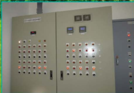
污水處理廠機電 自動化控制面盤
