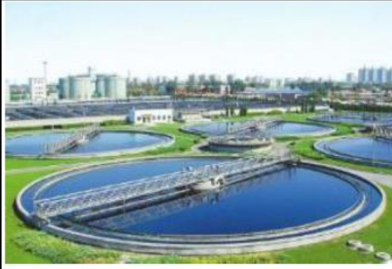
廢污水處理廠的二級沉降池
