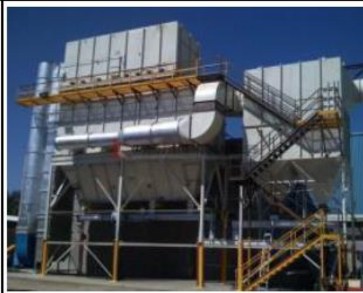
袋式集塵器去除空氣粒狀污染物
