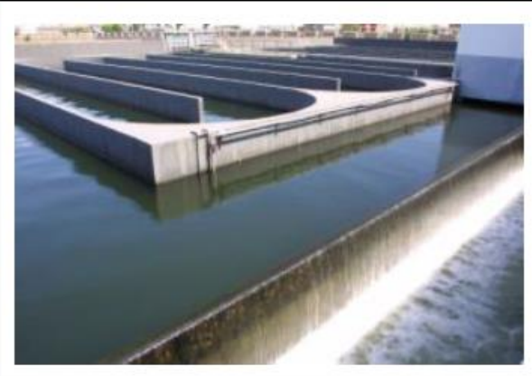
污水處理廠加氯消毒接觸槽
