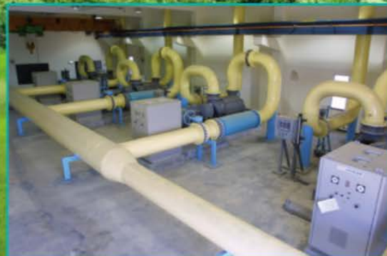
污水處理廠多段離心式鼓風機
