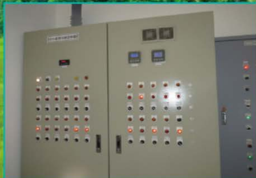
污水處理廠機電 自動化控制面盤
