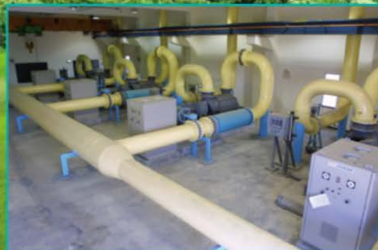
污水處理廠多段離心式鼓風機
