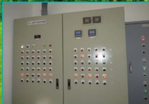
污水處理廠機電 自動化控制面盤
