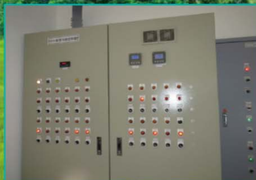
污水處理廠機電 自動化控制面盤
