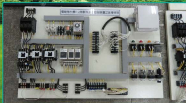
污水處理廠電動抽水機之馬達起動 及液位控制裝置
