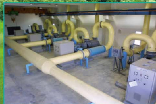
污水處理廠多段離心式鼓風機
