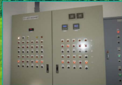
污水處理廠機電 自動化控制面盤
