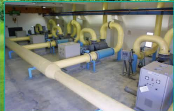
污水處理廠多段離心式鼓風機
