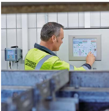
廢水廠PLC操作
