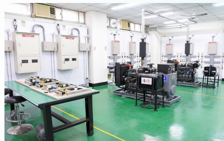
機電設備實習工廠(E棟)
