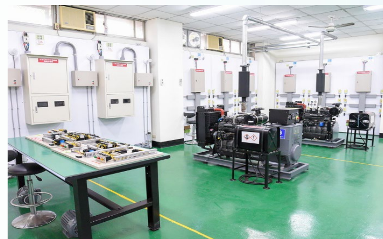
機電設備實習工廠(E棟)
