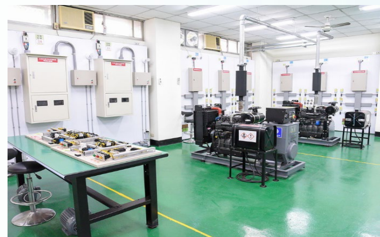
機電設備實習工廠(E棟)
