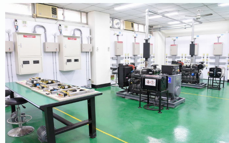
機電設備實習工廠(E棟)
